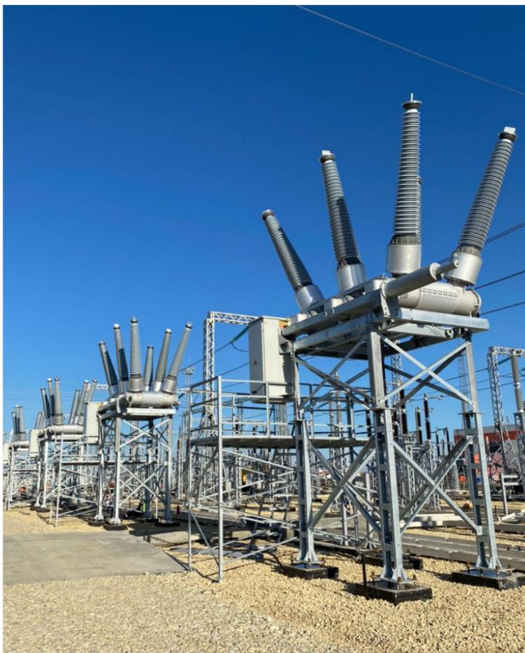
В декабре на ТЭС «Ударная» были поставлены 10 баковых выключателей ВЭБ-УЭТМ-220, изготовленных ПК ВВА. Оборудование предназначено для подстанции строящейся ТЭС.
